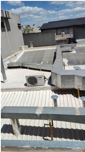
IMAGEN SITUACION EXISTENTE DUCTOS / SECTOR A INTERVENIR
